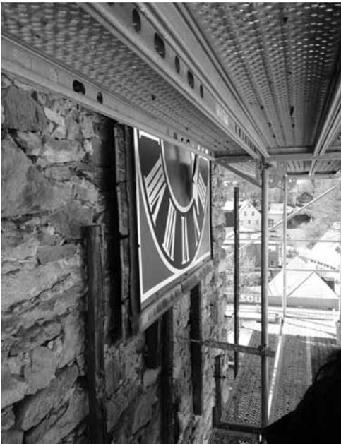
An der Westfasade wurden die Schiefer abgeschlagen und die Unterkonstruktion entfernt. Geplant ist, die Fassade zu verputzen und zu streichen.
